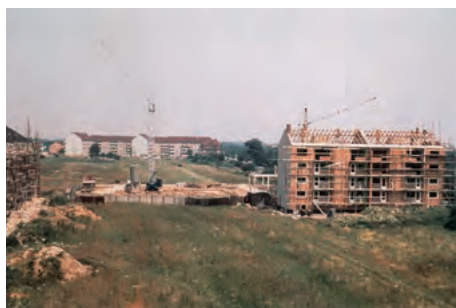
Neues Geschäftsfeld 1966: Bau eines Wohnhauses im Vinnhorster Weg
