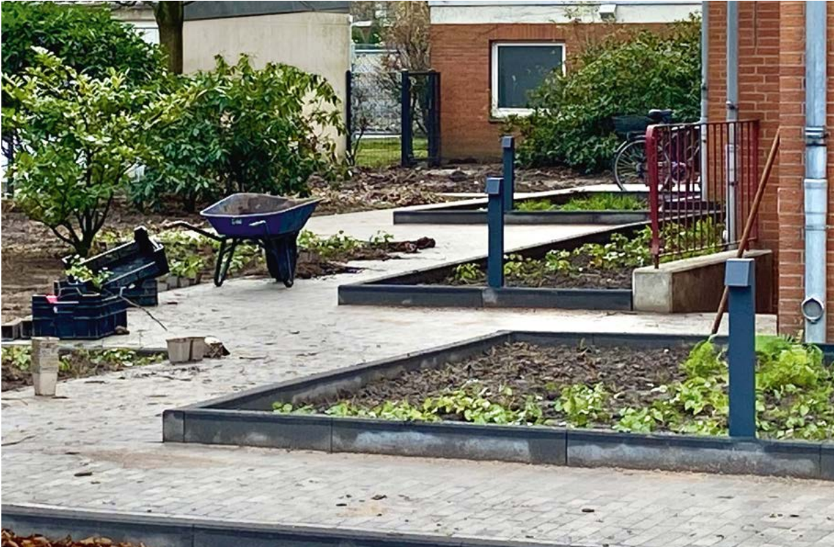
Die Neugestaltung der Außenanlagen ist fast fertig
