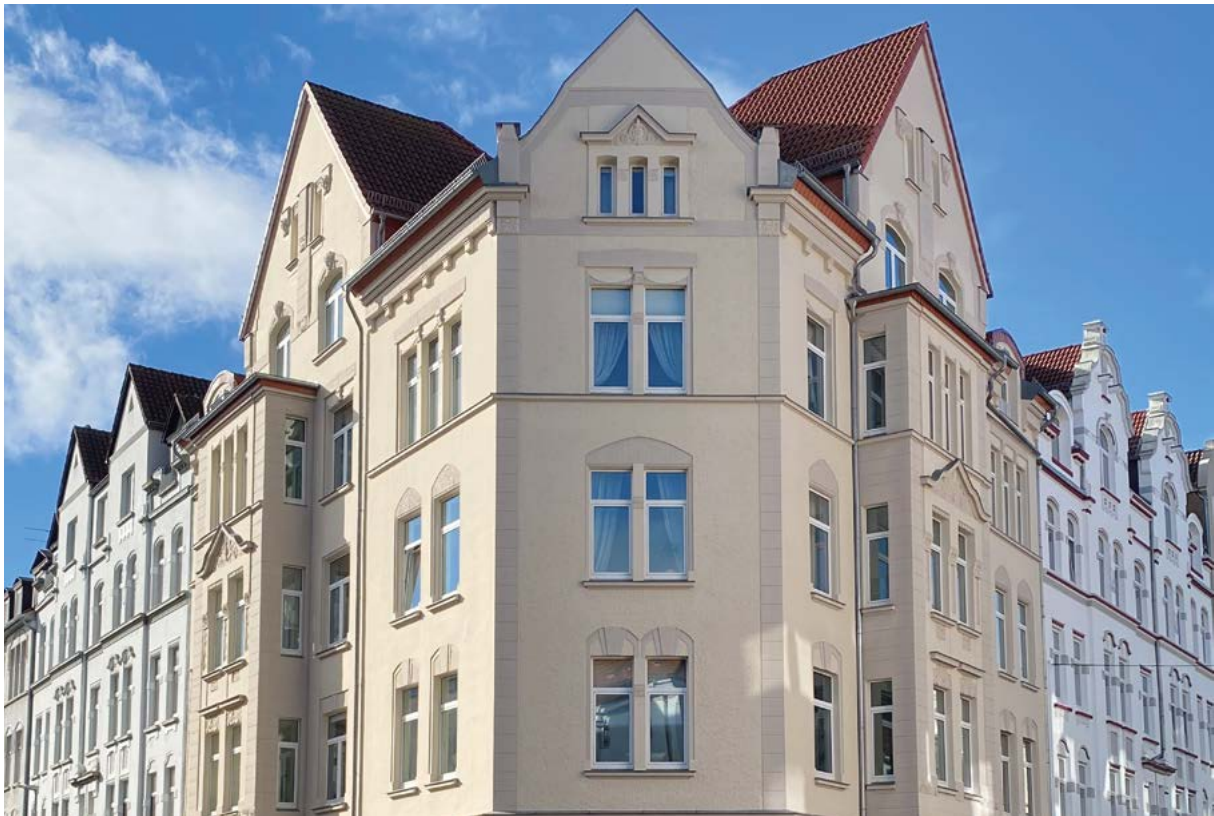
Die frisch renovierte Fassade des Eckhauses Große Düwelstraße 41
